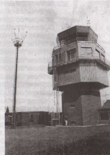
Seit November 1999 in Betrieb: Der neue Kontrollturm (Tower)
