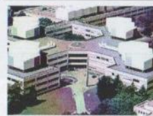
Die Universität der Bundeswehr in München – Hörsäle, Institute und Unterkünfte liegen auf einem Gelände und erlauben den Studenten kurze Wege
