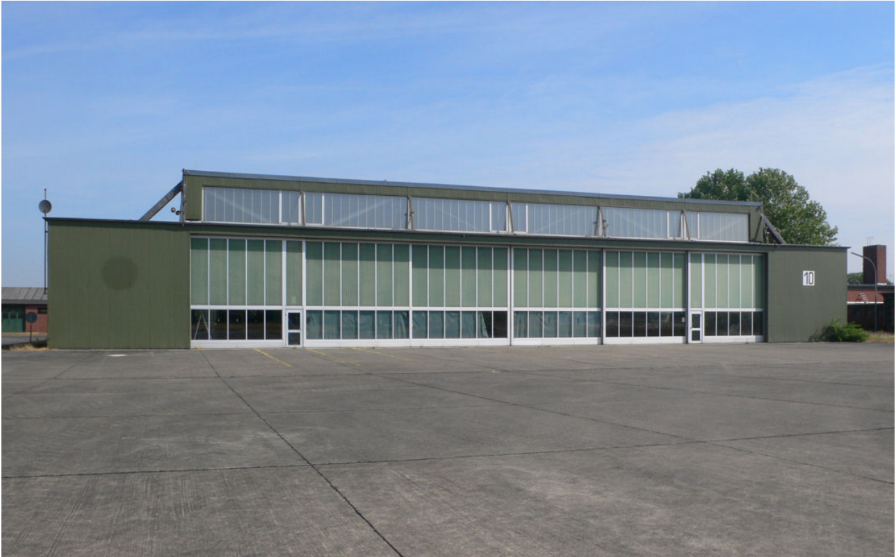
Halle 10 im nördlichen Bereich
