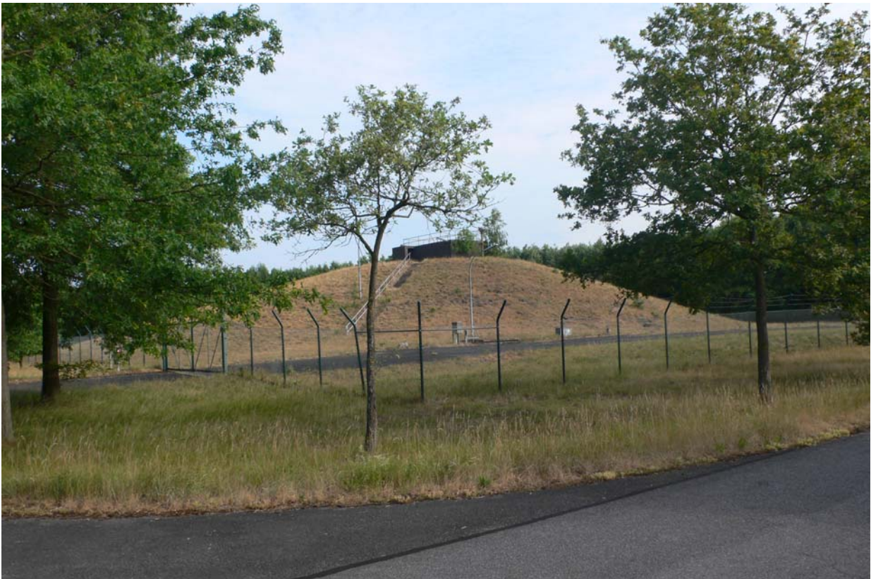
Treibstofftank im Tanklager Nord (POL-Lager)
